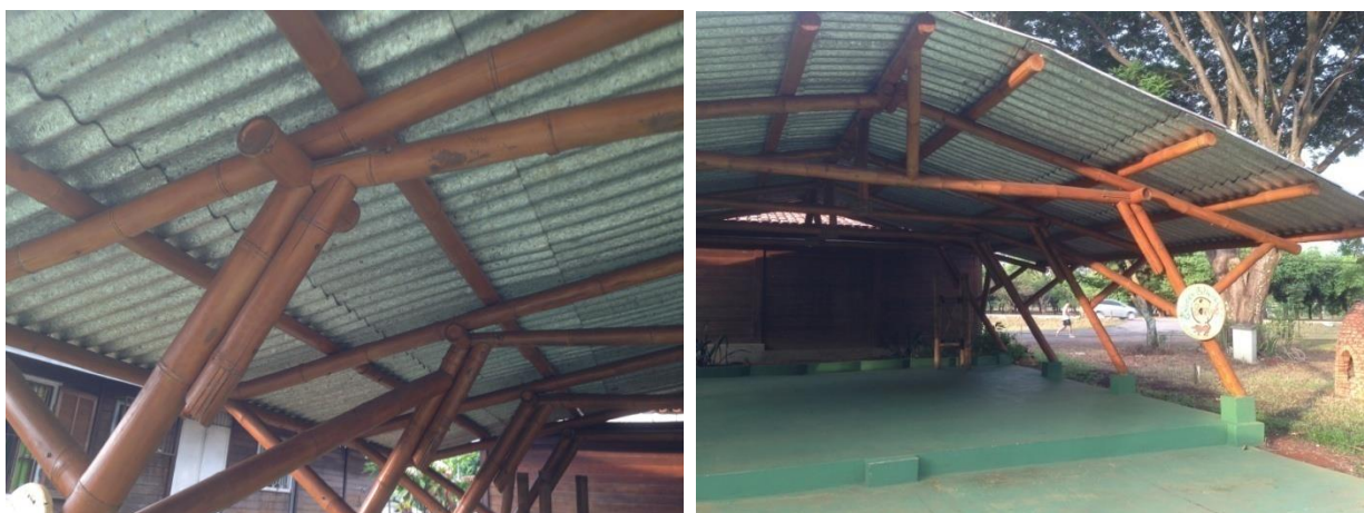
Figura 22: pavilhão de atividades (detalhe) - estrutura completa em bambu apresentando ótimo estado de conservação e boa resistência as cargas e intempérie (acervo pessoal) Figura 23: pavilhão de atividades - estrutura completa em bambu, sistema amarração e apoio, sapata bambuconcreto. (acervo pessoal)
