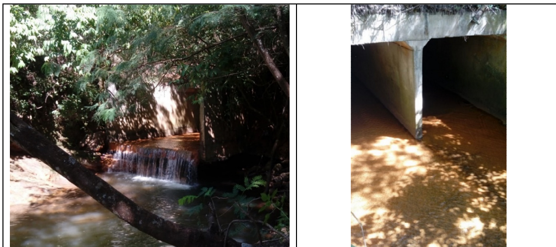
Figura 17. Lançamento da drenagem ao lado da ETE Sul, por meio de duas galerias quadradas de 2,5m
